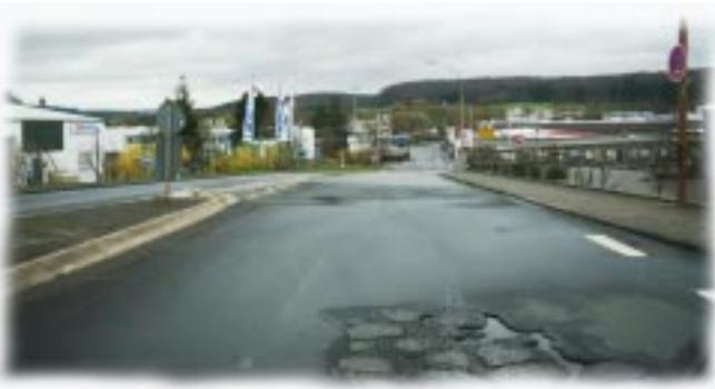
Die Straße am Ortseingang zum Industriegebiet ist von dem Schwerlastverkehr zerstört. Während die Industriegleise der Bahn zuwachsen, werden die Lastautos immer schwerer und schinden die Straßen.
