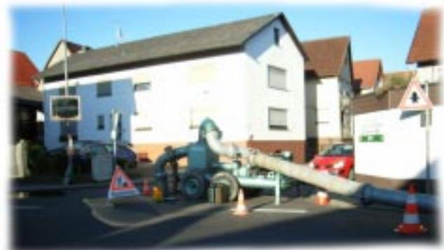
Auf der Kreuzung „Schmidtbrücke“ stand eine Pumpstation. Sie pumpte das Abwasser durch die oberirdischen Rohre, damit unterirdisch die Kanäle von innen mit einer überdimensionalen Wursthaut abgedichtet werden konnten.
