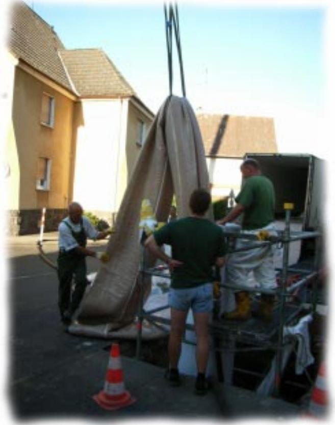
Das dicke Gewebe wird in den Kanal eingeführt, mit Wasserdruck zunächst an die Rohrwände angedrückt und dann mit einem Kunstharz gehärtet.
