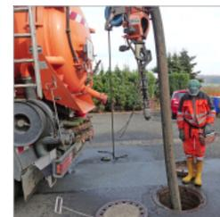
Ein Druckschlauch kann bis zu 52 m bis zum nächsten Kanaldeckel eingeführt werden. Er spritzt den Dreck locker.
