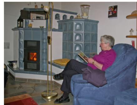
Wir kehrten bereits 1999 zu dem Prinzip zurück die Wärme dort zu erzeugen wo sie benötigt wird. Der moderne Kachelofen regelt elektromechanisch die Luftzufuhr immer optimal, spart damit Brennstoff und schädliche Abgase.
