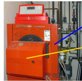
Im Heizungskeller steht der Kessel, in dem das Wasser von einem Öl-brenner erhitzt wird. Von hier aus wird es in alle Räume gepumpt.
