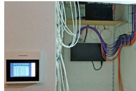
Ein Panel (Bildschirm für Sprechanlage mit Bedieneinheit), Router, Switch, WLAN-Verstärker und viele Kabel für Internet und Fernsehen gehören zur normalen Installation einer modernen Wohnung.
