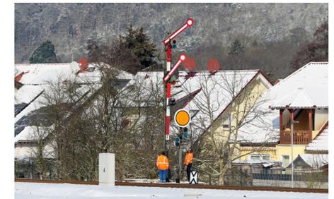
Am 8. Februar 2021 wird das Signal gewartet. Sind beide Flügel schräggestellt, bedeutet dies für den Lokführer „Langsamfahrt“, er muss dann über die Weiche auf das Gleis 1 fahren.
