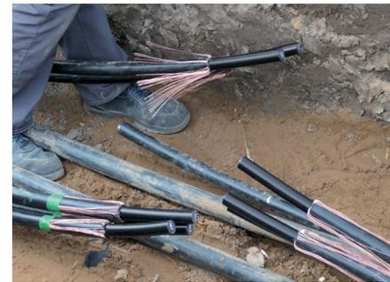
Billiger ist Aluminium. Deshalb sind die Kabel zum Dorf und in die Häuser aus Aluminium. Mit dünnen Kupferdrähten werden die Stromleitungen vor Magnetfeldern abgeschirmt.
