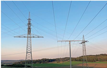
Strom wird mit unterschiedlichen Spannungen transportiert. Die Leitungen haben einen elektrischen Widerstand. Sie erwärmen sich, wenn Strom durch sie fließt. Diese Wärme geht an die Luft verloren. Bei hohen Spannungen sind die Verluste geringer. Deshalb wird Strom über weite Strecken mit 220 bis 380 Kilovolt geleitet. Umspannwerke transformieren den Strom für die Versorgung der Region auf 110 Kilovolt.
