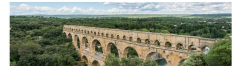
Die Römer bauten viele Kilometer lange Aquädukte, in denen sie Wasser zu ihren Städten leiteten. Täler überspannten sie dazu mit imposanten Bauwerken. Die Abweichung von der Waagerechten musste so groß sein, dass das Wasser in ausreichender Menge floss, durfte aber nicht zu groß sein, dass es nicht zu schnell strömte. Es ist erstaunlich, wie genau die Römer diese Neigung messen konnten.
