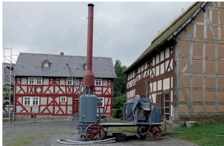
Bei Fachwerkhäusern kann man sehr gut studieren, welche Bedeutung senkrecht und waagrecht bei Bauwerken haben. Die senkrechten Balken tragen die Last nach unten ab. Die waagerechten Balken halten das Bauwerk in der Länge zusammen und die schrägen Balken versteifen es.
