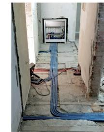
In meinem Elternhaus lagen die Heizrohre fast ungedämmt in den Außenwänden. Dies haben wir beim Umbau geändert. Alle Leitungen liegen im Boden und führen von dort zu den Heizkörpern.
