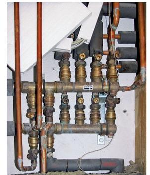
Das heiße Wasser für die Heizkörper läuft von Heizkörper zu Heizkörper in einem Rohr. Dies verursacht hohe Energieverluste. Ich kann wenigstens ganze Heizstränge in der Verteilung abstellen, so spare ich eine Menge Energie.
